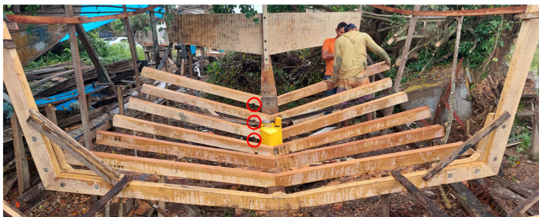
Figura 6– Instalação da parte inferior das cavernas, os círculos em vermelho indicam as bueiras. Foto: Acervo pessoal (2022).
