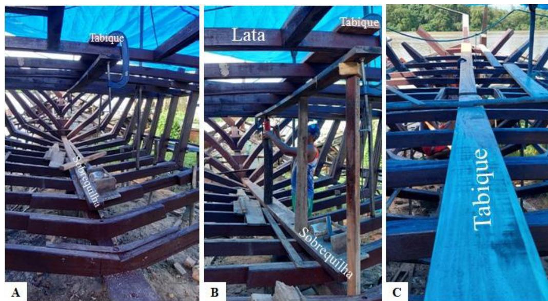
Figura 9– Na imagem A. disposição das peças do tabique e da sobrequilha; B. etapa de suspensão dos tabiques; e C. vista superior do tabique. Foto: Acervo pessoal (2022).
