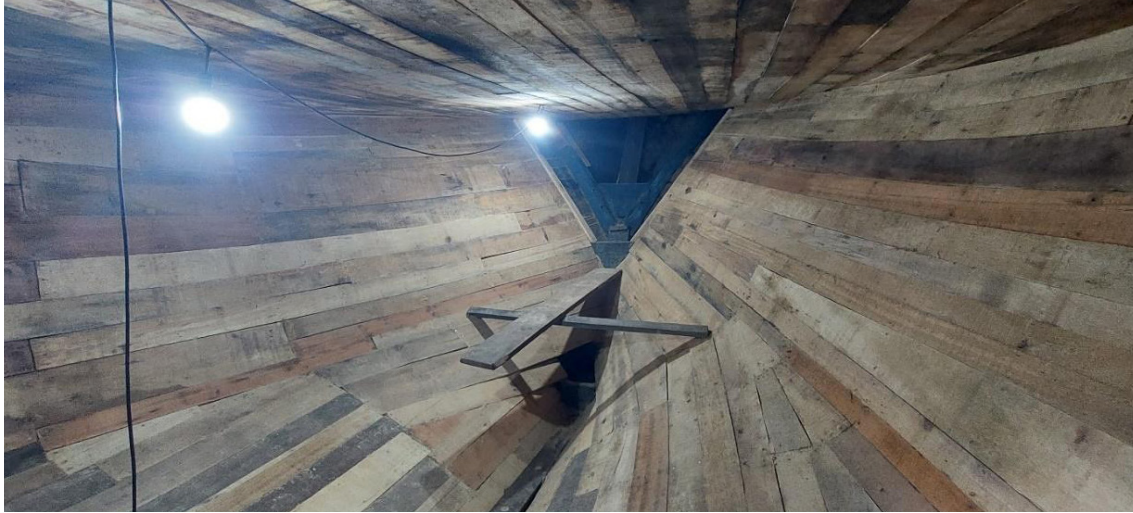
Figura 11 – Revestimento interno em madeira. Foto: Acervo pessoal (2022).
