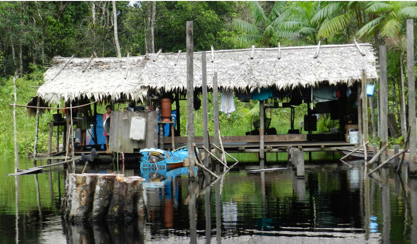
Figura 2 – As moradias tradicionais dos moradores do Mapuá também são construções fortemente marcadas pela influência indígena, evidenciadas principalmente na utilização de matérias-primas retiradas das florestas como a madeira para erguer a estrutura principal (esteios) e a palha de ubussú para a cobertura.
