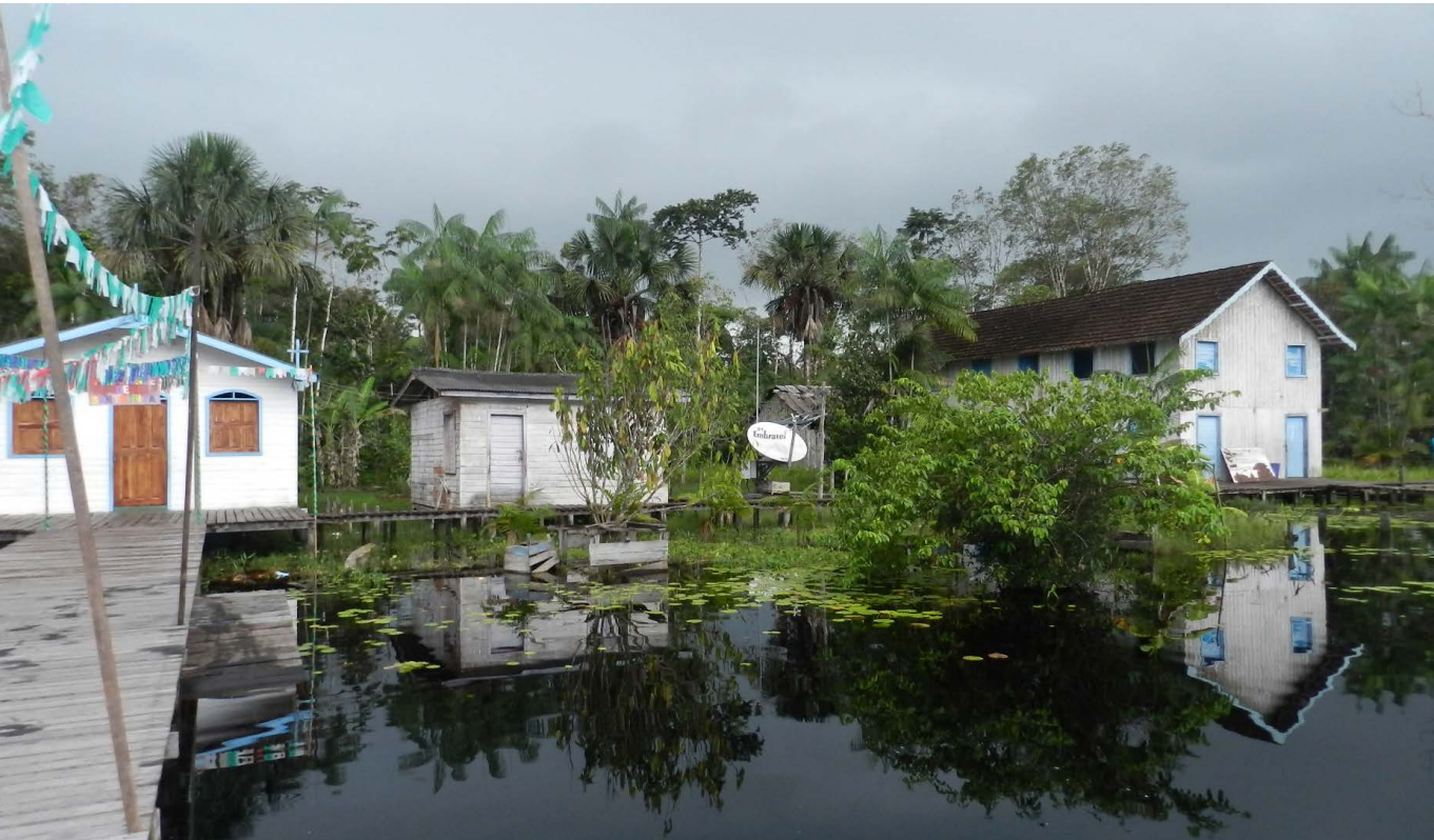
Figura 6 – Casarão de dois andares localizado na comunidade Santa Rita, construído no contexto de retomada das negociações com a borracha no mercado internacional durante a II Guerra Mundial na década de 1940. Na atualidade é uma casa comercial de gêneros variados destinados as necessidades básicas da comunidade.
