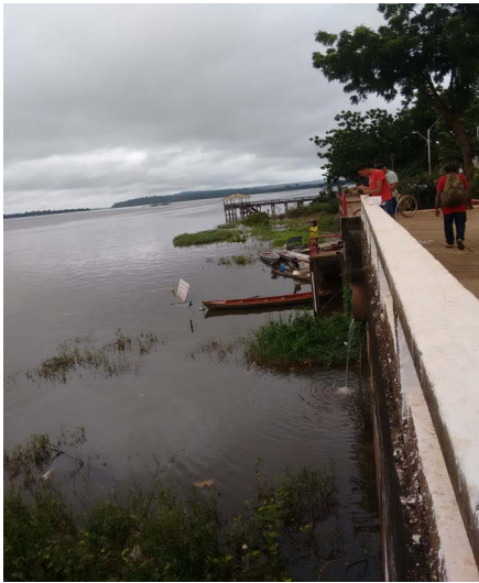
Figura 4. Vão da escada de acesso à margem alagada e pescaria no esgoto. Foto Gutemberg Guerra, 14 de março de 2016
