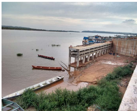
Figura 7. Moradores de rua abrigados no ancoradouro em construção. Foto Gutemberg Guerra, 20 de Janeiro de 2016.
