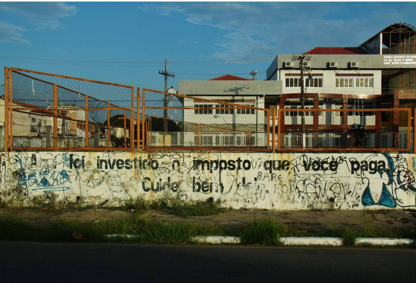
Figura 03. Pequena grande chaga . Quadra esportiva localizada na Av. Almirante Tamandaré, Cidade Velha. Fotografia: Aymee Marçal.
