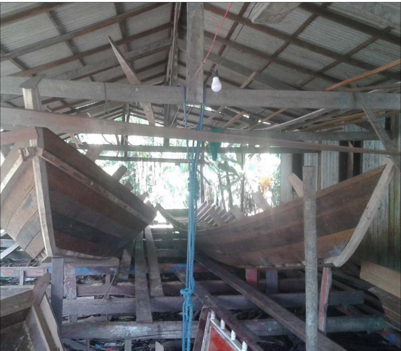
Figura 8 - Rabetas em fase de construção. Foto: Rosenildo da Costa Pereira (25 nov. 2018).
