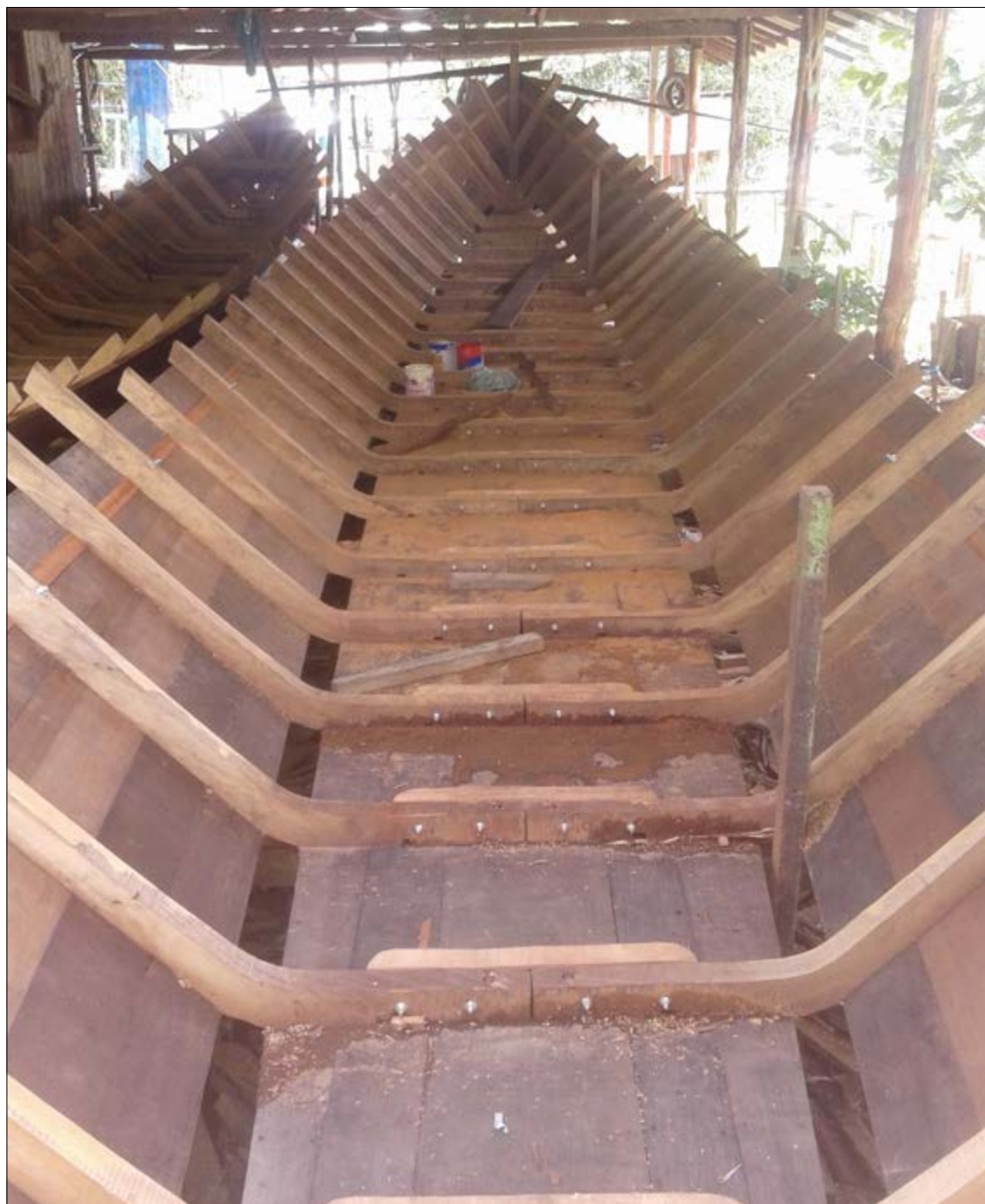
Figura 7 - Rabetas em fase de construção. Foto: Rosenildo da Costa Pereira (25 nov. 2018).
