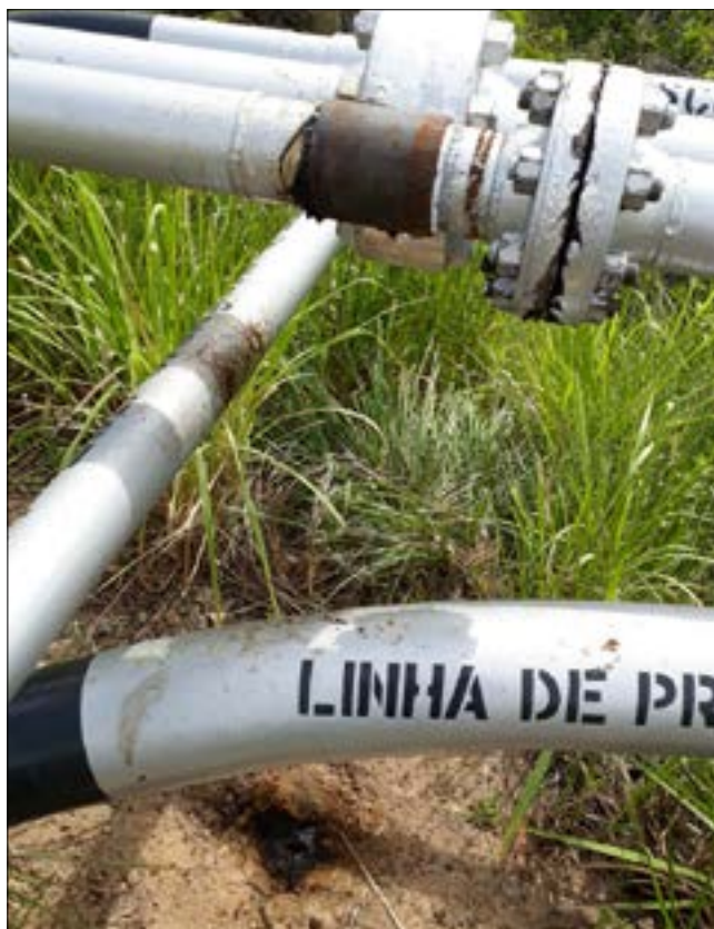
Figura 11 - Gotas de petróleo pingando no chão. Essa imagem foi captada durante uma atividade pedagógica em parceria com Dom João, em janeiro de 2020, em uma tubulação de petróleo que liga a Trincheira de Marapé à refinaria Landulpho Alves. Ela é um testemunho da precariedade da infraestrutura do petróleo nas áreas de manguezal, e um modo de captarmos formas de perturbação de longa duração quase imperceptíveis.
