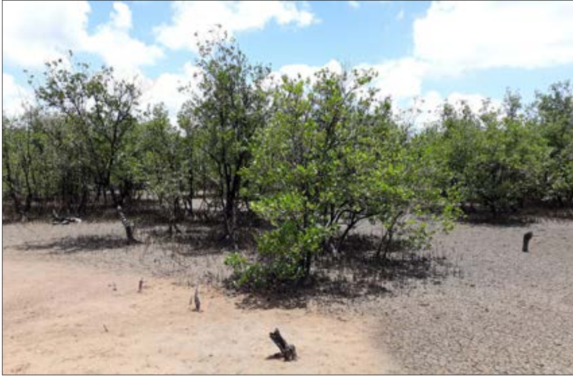
Figura 14 - Limite entre o manguezal e o aterro para a exploração petrolífera. Há muitos aterros como este, que ocuparam áreas de manguezal, formando caminhos de terra firme em meio aos bosques de mangue. Estes lugares produziram ambientes propícios para a ocupação de guaiamuns, que são os crustáceos que vivem em terra firme, em zonas de transição entre o manguezal e a floresta. Nos casos dos aterros, as zonas não são de transição, mas de ruptura. Boa parte destes ambientes de ruptura, hoje desativados, serve de trajeto para pescadores e marisqueiras em direção aos seus lugares de pesca. Eles não são ambientes propícios a caranguejo-uçá, aratus, siris, ostras e sururus, espécies que aí viviam e que perderam a habitabilidade. Foto: Rafael Palermo Buti (out. 2019).
