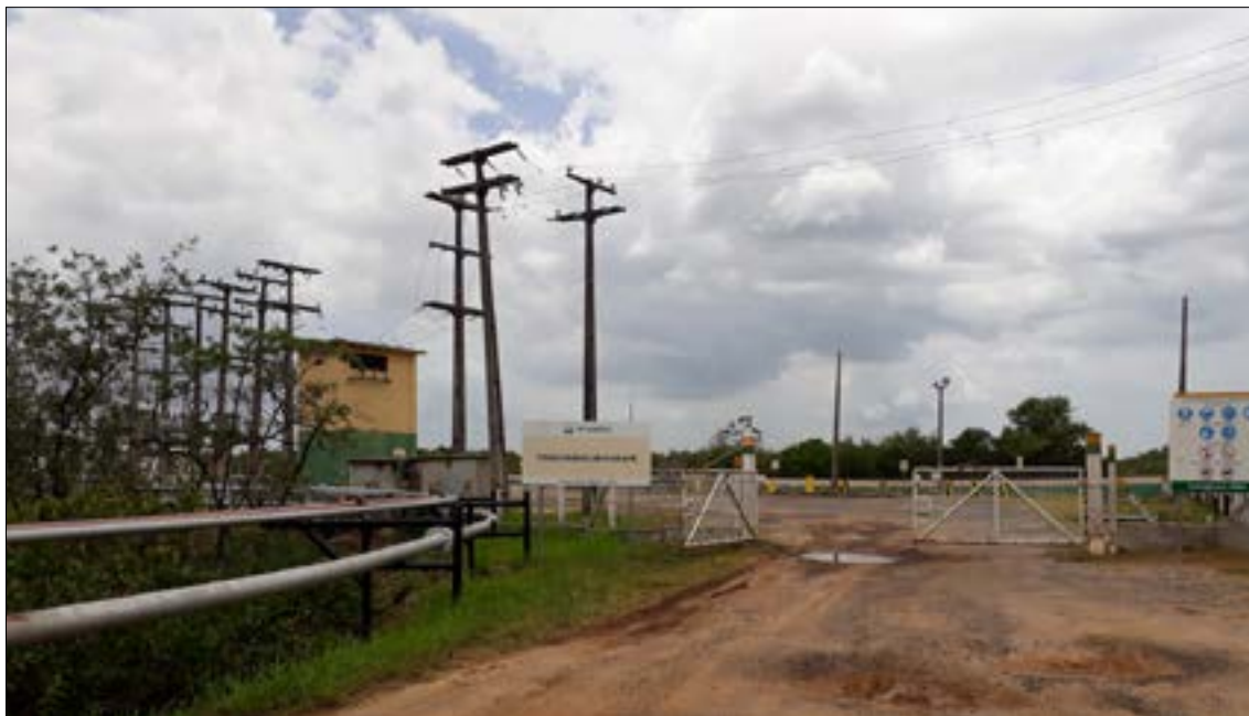
Figura 8 - Trincheira de Marapé, um dos pontos de exploração do petróleo. Os tubos à esquerda são chamados de “linhas” e levam o petróleo a um reservatório localizado em uma das entradas da cidade. Este reservatório é ligado por um sistema de linhas à refinaria Landulpho Alves, que, por sua vez, é conectada ao polo industrial de Camaçari e ao porto de Aratu. A Trincheira bombeia o petróleo do coração do mangue ao (fim do) mundo. Foto: Rafael Palermo Buti (2018).
