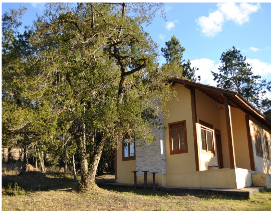
Figura 4: Podocarpus lambertii Klotzsch ex Endl., Parque Estadual da Serra do Papagaio (PESP), casa na sede do parque em Alagoa – MG (Fonte: Fotografias de Erika Cortines em 05 de maio de 2018).
