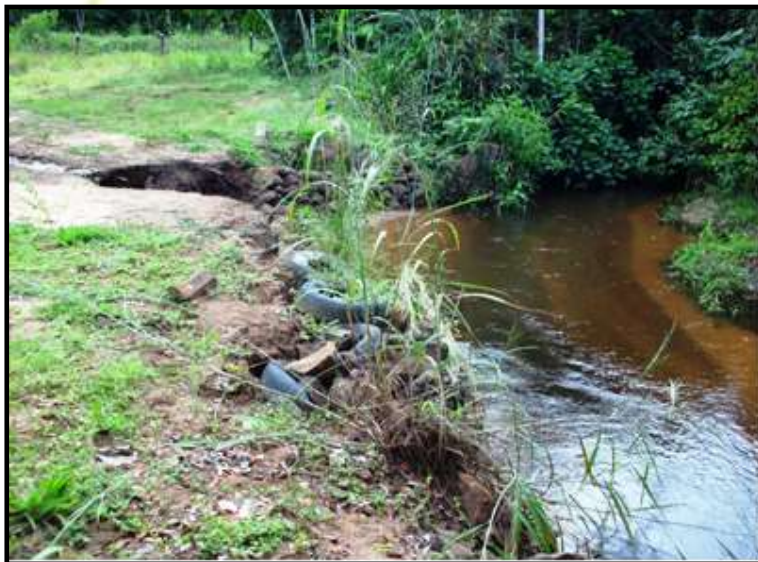
Foto 02: Utilização de pneus descartados e pedras na tentativa de conter erosão nas margens do córrego mato verde Fonte: Vanderley, L. D. M. (abril/2011).
