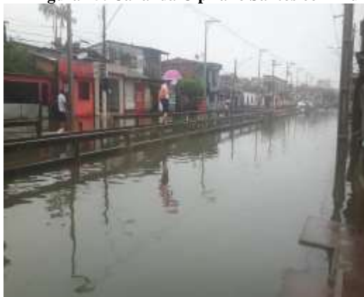
Figura 15: Canal da Cipriano Santos com inundação
