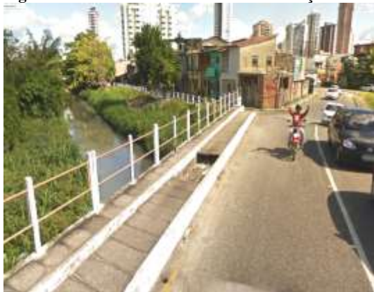
Figura 18: Canal da 3 de Maio sem inundação
