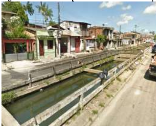
Figura 14: Canal da Cipriano Santos sem inundação
