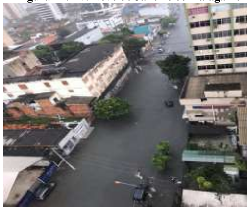
Figura 17: Tv. Nove de Janeiro com alagamento
