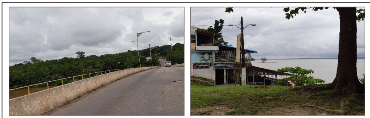
Figura 7. Ilha de Outeiro, ponte de acesso à Ilha (a esquerda) e residências a margem da baía de Santo Antônio
