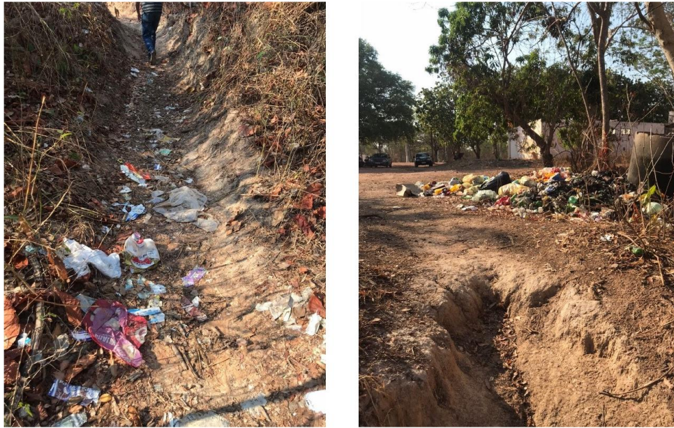
Figura 3 - Degradação e lixo sanitário
