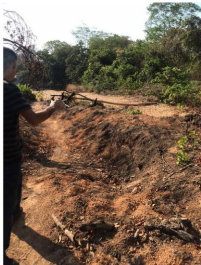
Figura 2 - Entorno da ponte de ferro/solo exposto
