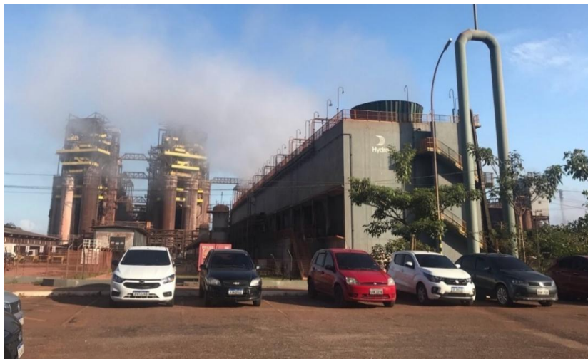
Figura 9: Estruturas com água a vapor na entrada da Hydro Alunorte em Barcarena – PA
