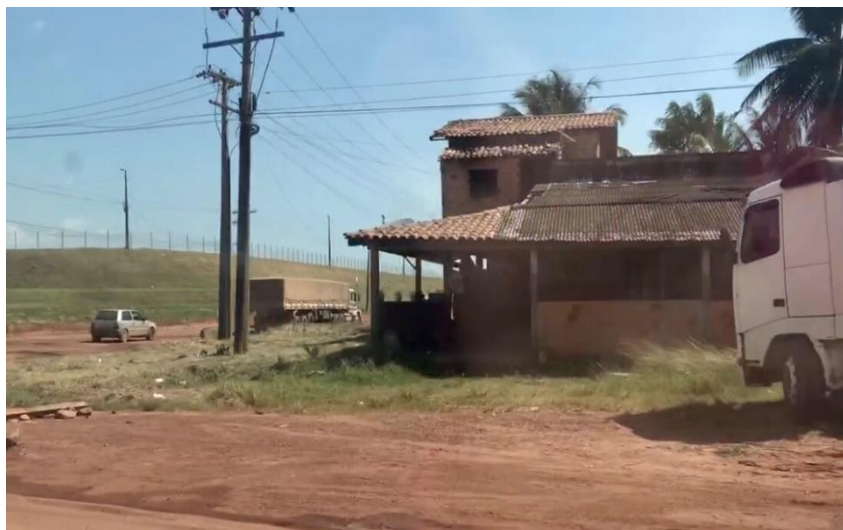
Figura 8: Bacia 3 próxima de estradas vicinais e ocupações
