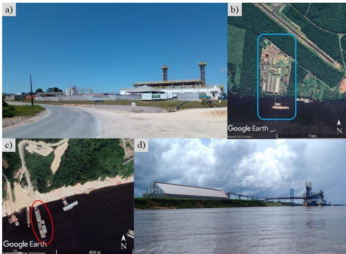
Figura 3. Novos sistemas de engenharia no eixo Manaus-Itacoatiara/Silves/Itapiranga. A) Planta de processamento de GN e de GNL no município de Silves-AM (imagem dos autores em 29/08/2022); B) Porto da empresa Hermasa/Amaggi destacado pela linha azul (imagem do Google Earth); C) Porto do tipo ETCF da empresa Bertolini no município de Manaus destacado pela linha vermelha (imagem do Google Earth); D) Novo porto no distrito de Novo Remanso (imagem dos autores em 15/04/2023).
