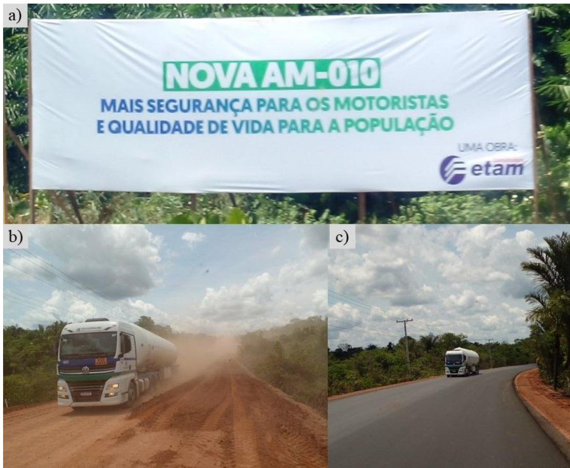
Figura 5. Modernização da rodovia AM-010 via tecnosfera e psicosfera. A) Placa da construtora ETAM referente às obras rodoviárias, destacando as benesses das obras; B) Carreta transportando GNL no trecho em obras de terraplanagem; C) Carreta transportando GNL em trecho recém-asfaltado. Imagens dos autores de 07/08/2022 e 28/08/2022
