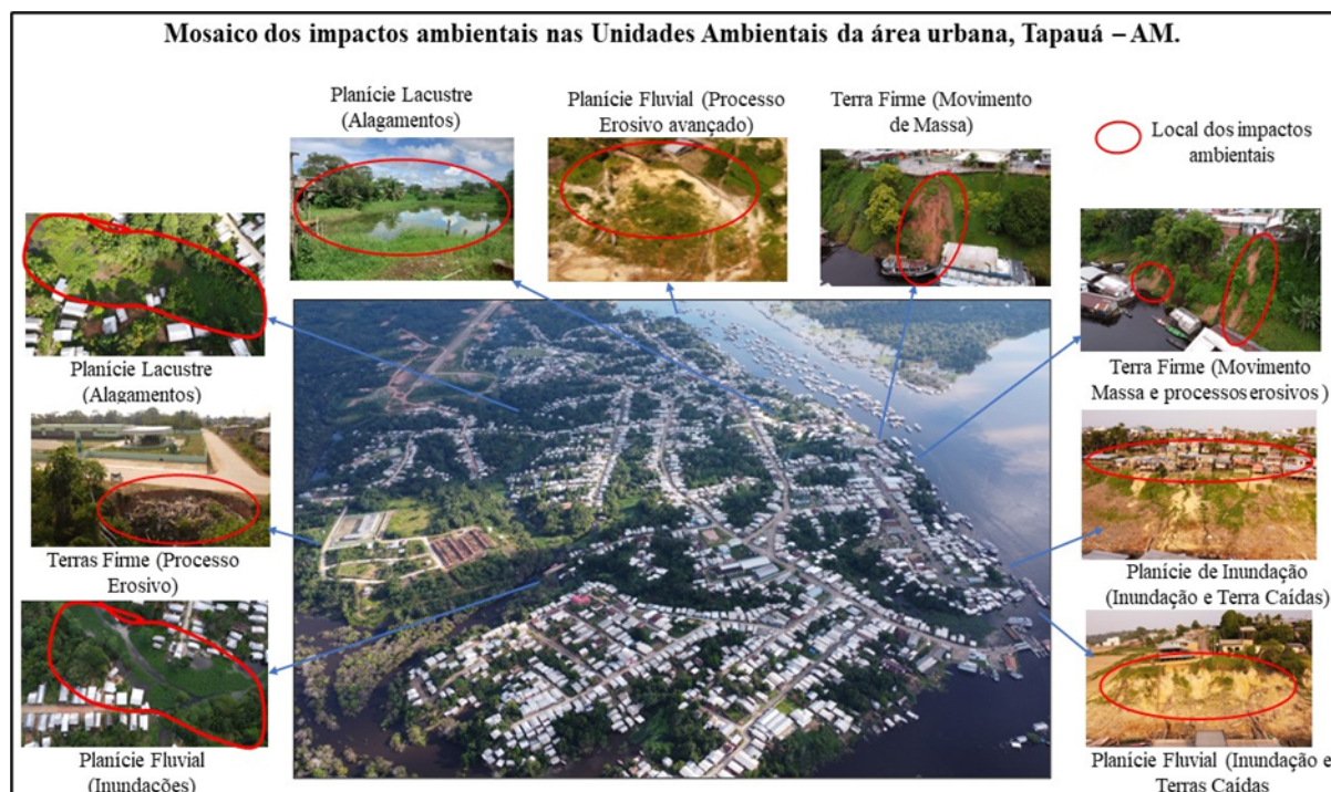
Figura 8: Impactos ambientais nas Unidades Geoambientais na área urbana, Tapauá-AM.
