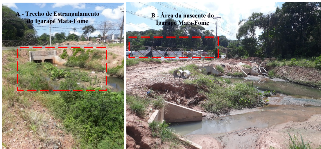
Figura 3 - Ponto 01 em destaque, A) estrangulamento e assoreamento da calha fluvial; B) terreno onde está a nascente do Igarapé Mata-Fome.
