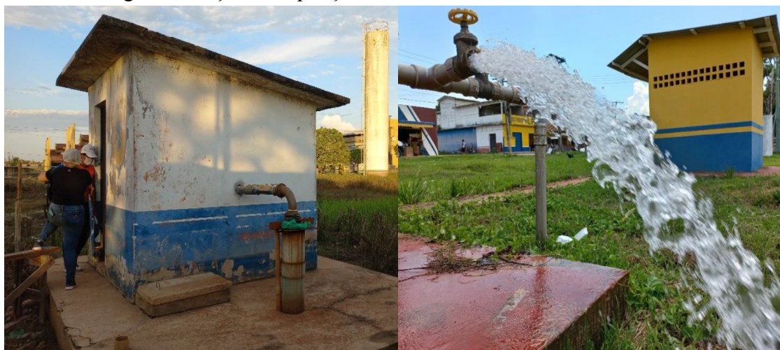
Figura 2: Poços de captação com reservatório e sem reservatório
