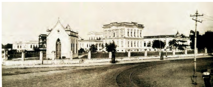
Figura 4 - Fachada da Santa Casa de Misericórdia no início do século XX
