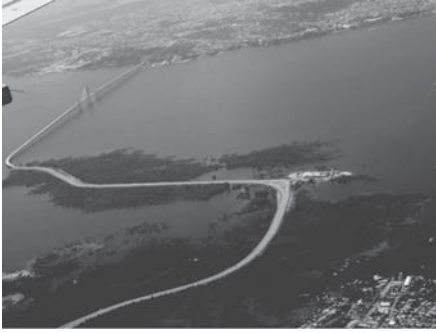
Figura 1. Vila do Cacau Pirêra (abaixo), distrito da cidade de Iranduba. O transporte de tijolos e telhas era feito até Manaus (acima) pelo porto dessa vila, antes da construção da ponte Rio Negro. Foto do autor, 2011.
