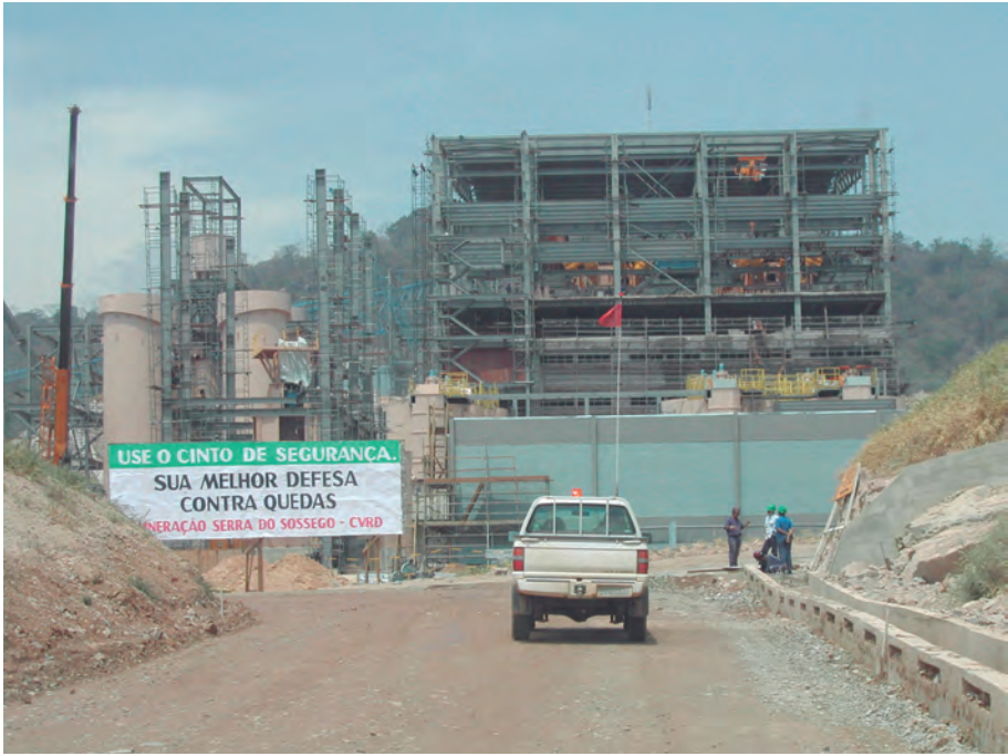
Figura 5 - Vista do canteiro de obras da usina de beneficiamento da Mineração Serra do Sossego, Canaã dos Carajás, Pará, 2003.
