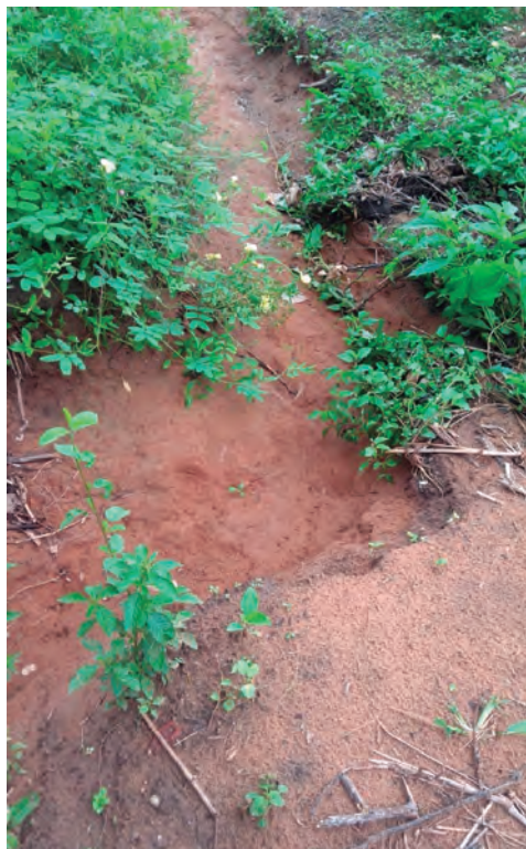
Figura 3 - Processo erosivo provocado pela água da chuva
