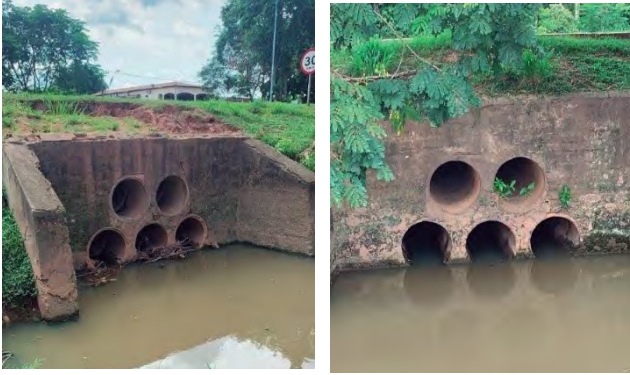
Figura 2 – Bueiro da Rod. BR-010 na bacia do riacho Bacuri em Imperatriz-MA
