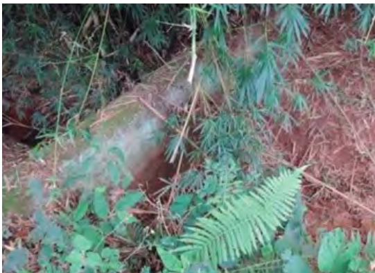
Figura 9 – Barreira de cimento da nascente
