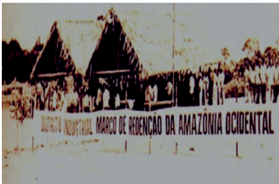
Foto tirada em 30 de setembro de 1968, na ocasião de lançamento da pedra fundamental do Distrito Industrial da Zona Franca de Manaus. Na faixa, lê-se: “Distrito Industrial: marco da redenção da Amazônia Ocidental”. Acervo SUFRAMA, 2004.
