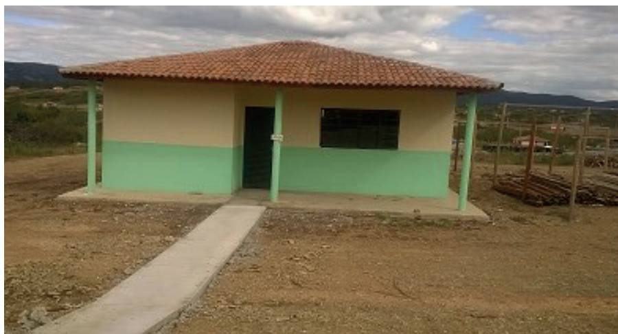
Figura 2 – Casa em construção na vila Cacaré
