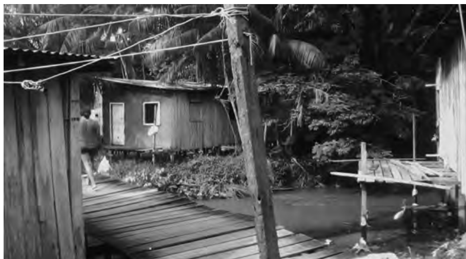
Figura 1 - Trecho de estiva para circulação de moradores da comunidade
