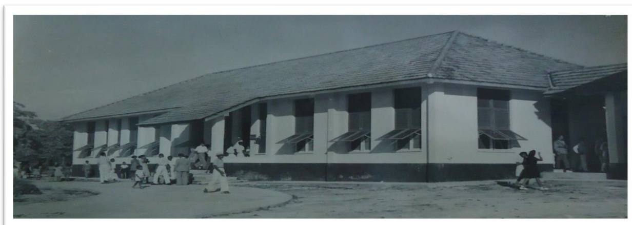
Figura 2 - Vista do hospital já concluído
