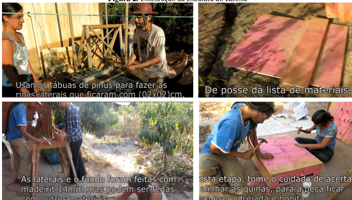
Figura 2. Construção da estrutura do caixote
