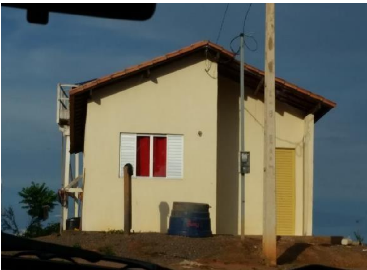
Figura 03: Casa do RRC, estrutura da Norte Energia.
