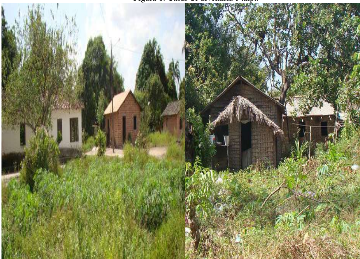
Figura 6: Casas de alvenaria e taipa
