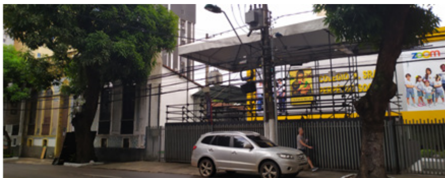
Imagem 2: Parte do conjunto arquitetônico de Nazaré
