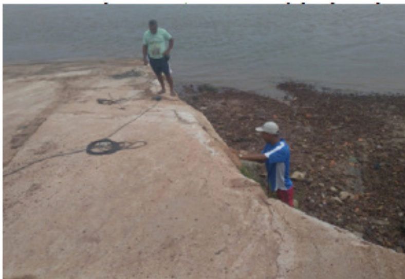
Figura 1 - Manutenção do trapiche de acesso a balsa ou barcos de pequeno porte- trapiche Salvaterra
