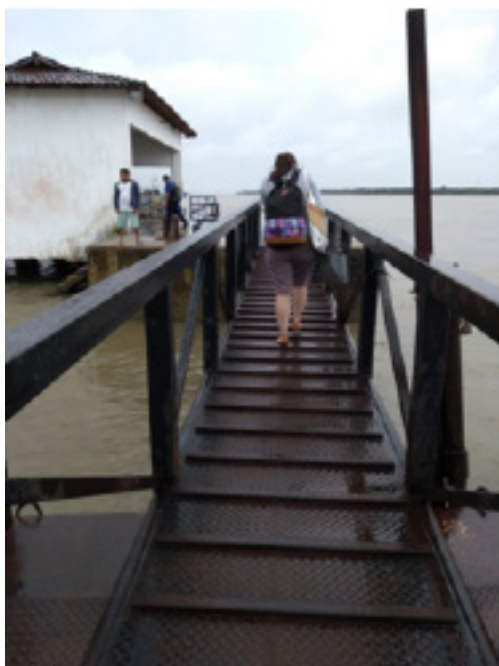
Figura 3 - Ponte de acesso entre a embarcação e o trapiche de Soure
