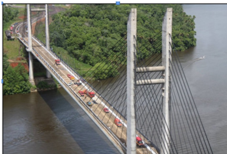
Imagem 02: Ponte Binacional sobre o rio Oiapoque
