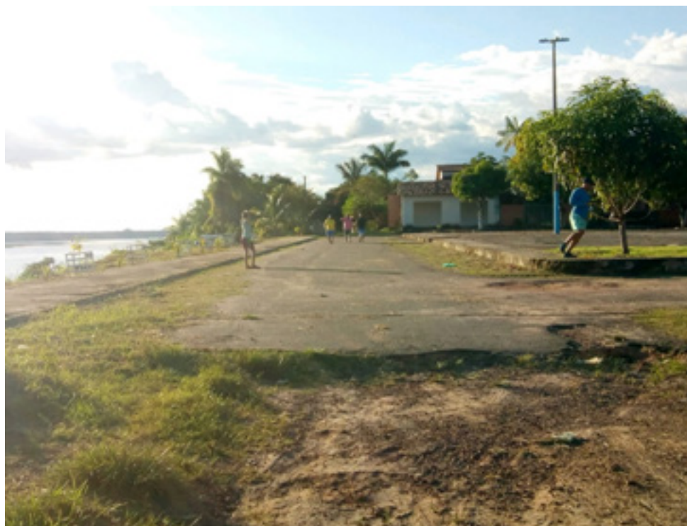
Figura 11: Situação atual da Rua 15 de Novembro
