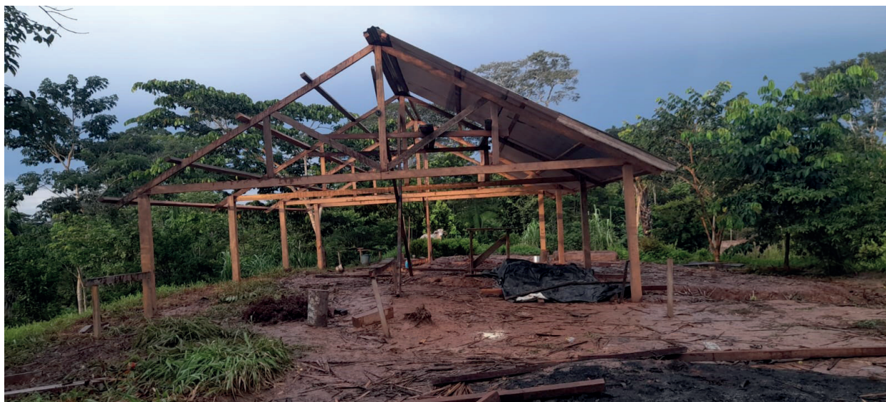
Figura 4 – Construção em 2022 de refeitório e cozinha de uso comunitário na aldeia Segredo do Artesão, na Praia do Carapanã, em terra indígena dos Huni Kuin, no Acre. Fotografia de Bixku Huni Kuin.
