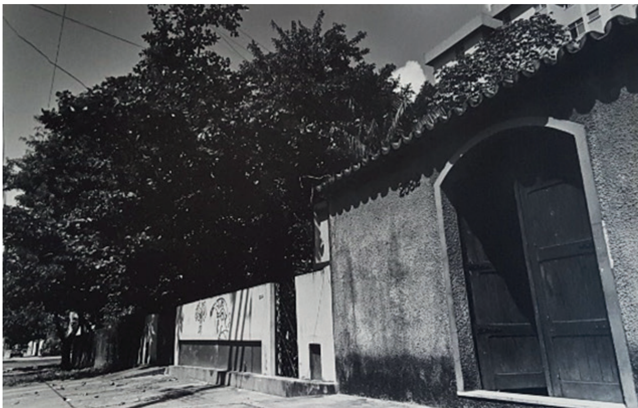
Figura 01 – Fachada principal da Galeria na Travessa 9 de Janeiro.
