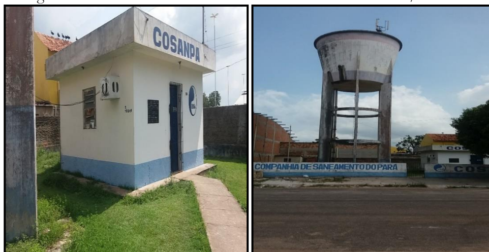
Figura 3 — Estrutura da COSANPA em Santa Luzia do Pará/PA.
