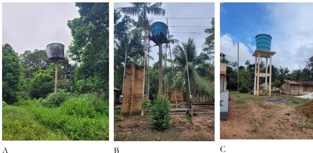
Figura 10 – Sistema de abastecimento de água na comunidade Boa Vista do Itá, Santa Izabel do Pará-PA.
