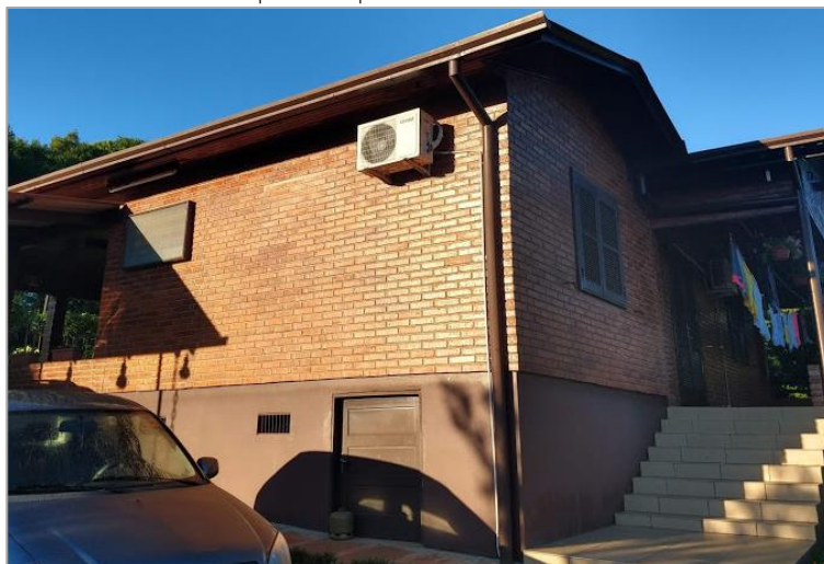
Figura 3 - Casa comentada por P4 quanto ao chanfrado no acive do terreno
