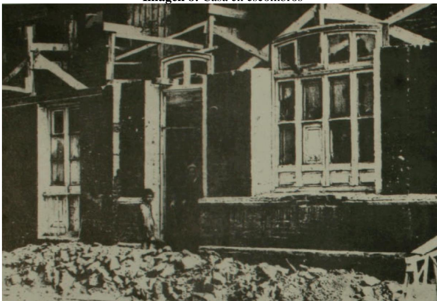
Imagen 8: Casa en escombros
