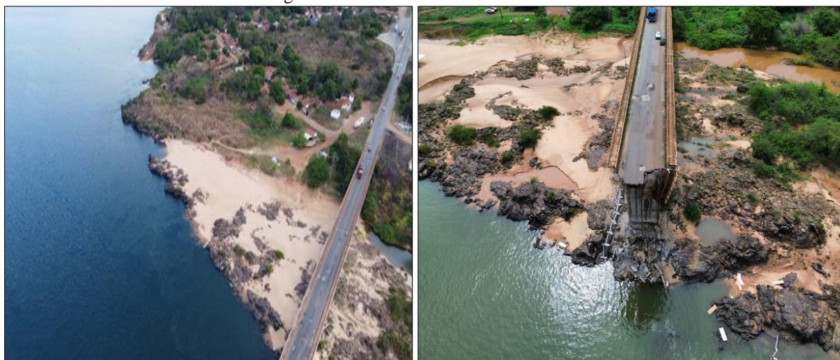
Imagem 1: Ponte – divisa Maranhão-Tocantins
