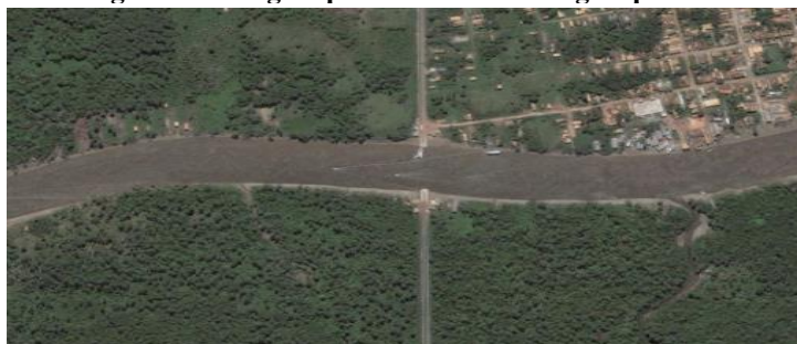
Figura 3 - Imagem por satélite do Rio Igarapé-Miri
