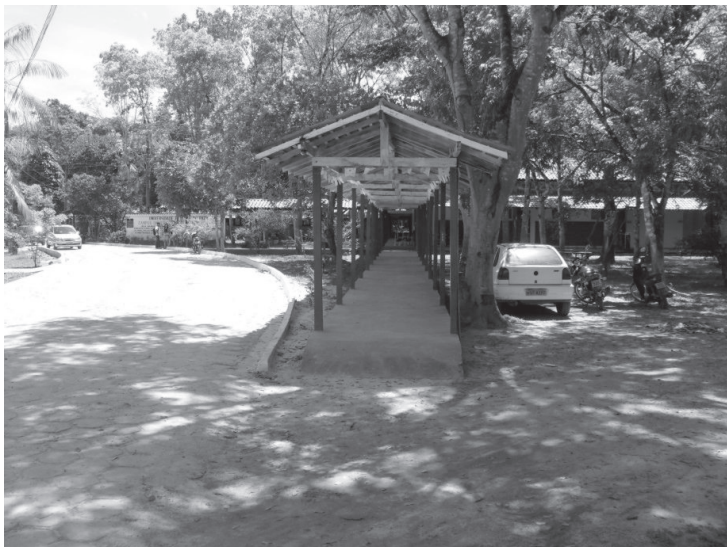
Fotografia 06: Passarela de acesso ao bloco de sala de aula do Curso de Letras.
